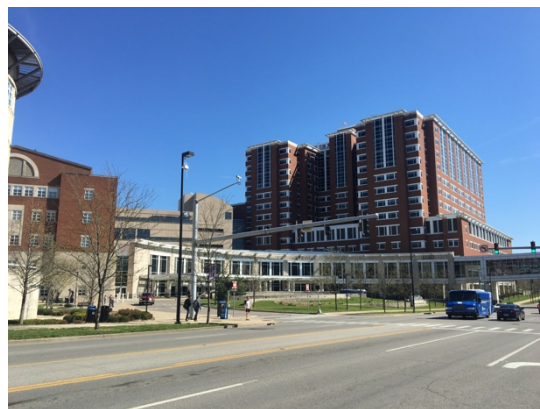
*UK hospital の外観
